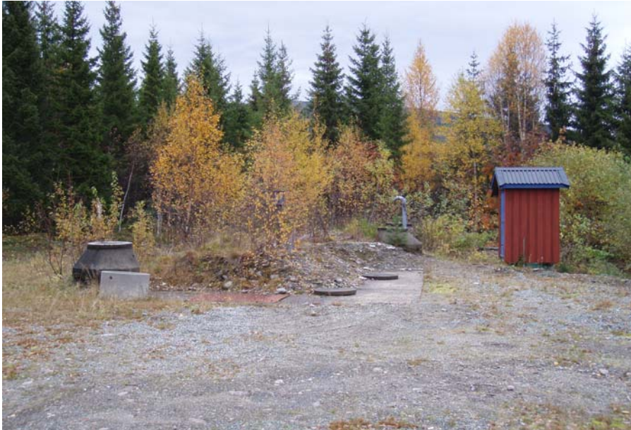
- Infiltrasjonsanlegg på nedsiden av skisenteret
