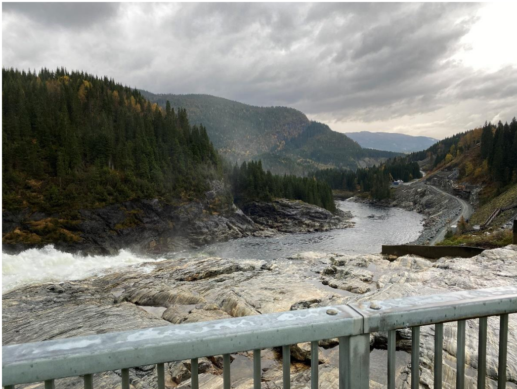
Utsikt mot nye Nedre Fiskumfoss Kraftstasjon
