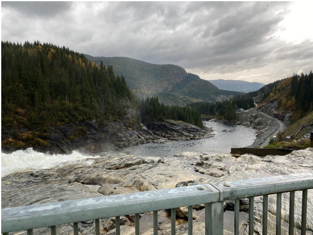
Utsikt mot nye Nedre Fiskumfoss Kraftstasjon
