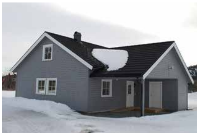
Kommunal utleiebolig: Sakrimoen 14, Harran
