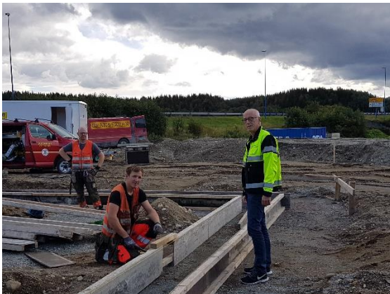
Oppstart av arbeidet med nytt renseanlegg på Mediå
