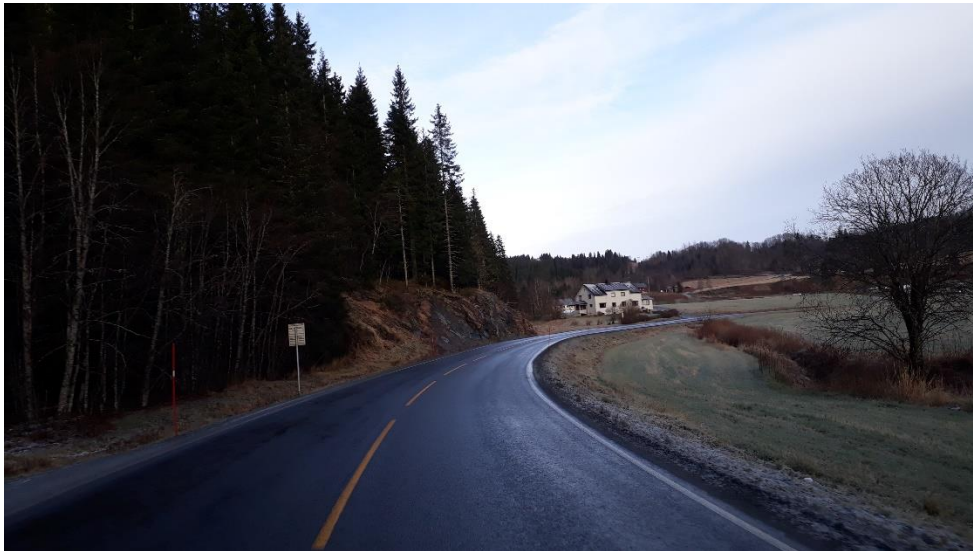
E6 Fossland planlegges utbedret
