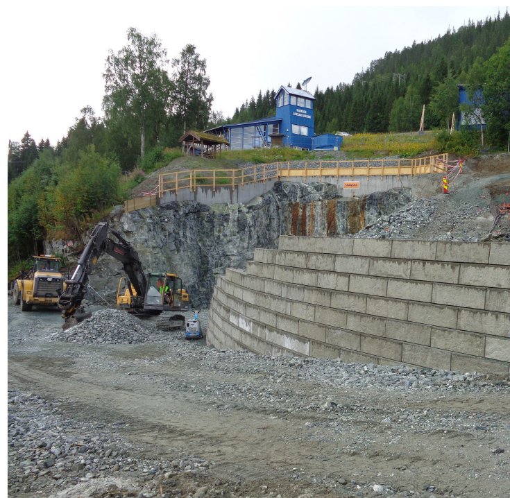
Sagmur til portal: Dette bildet viser adkomstveien ned til portalbygget. Her er det satt opp en sagmur som blir stående permanent.
