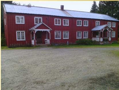
Våningshuset på Mediå. Foto: SG
