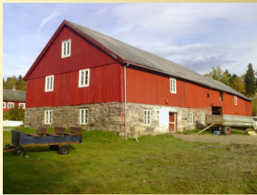
Driftsbygning på Grong bygdamuseum. Foto: Gunnbjørn Moa
