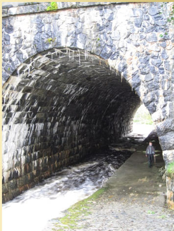
Kulvert på Nordlandsbanen. Foto: JL
