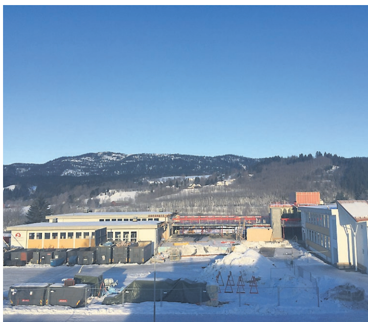
Gjennomføringen med prosjektet GBU og kulturbygg startet opp i september 2015.
