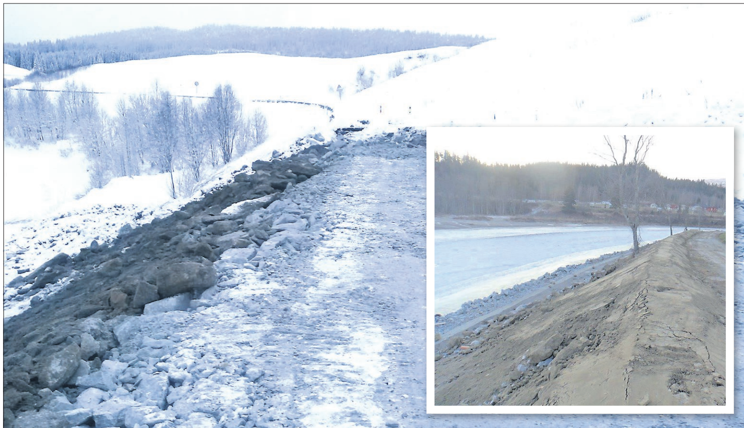
Gjenoppbygging av kommunal vei ved Nes bru. ILL-Foto.
