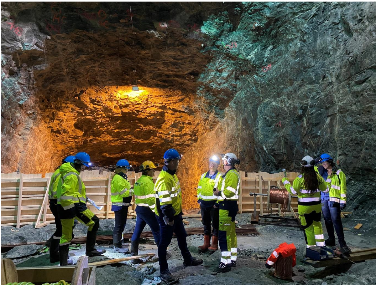
Formannskapet på befarig ved Nye Nedre Fiskumfoss kraftstasjon
