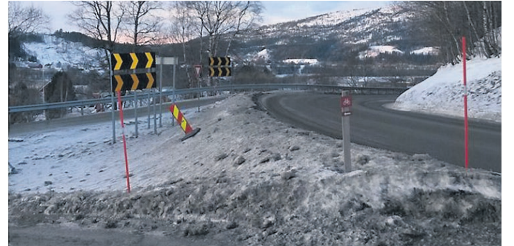
ULYKKEUTSATT: Bildet er fra Vie-svingen og er et eksempel på en ulykkesutsatt strekning i Grong kommune.
