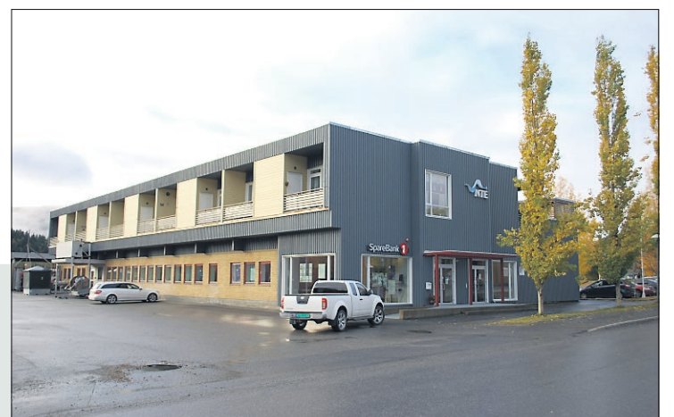
NTE-BYGGET: I starten av 2016 blir det igangsatt en relativt omfattende ombygging av lokalene som skal brukes av den kommende tannklinikken i NTE-bygget.
