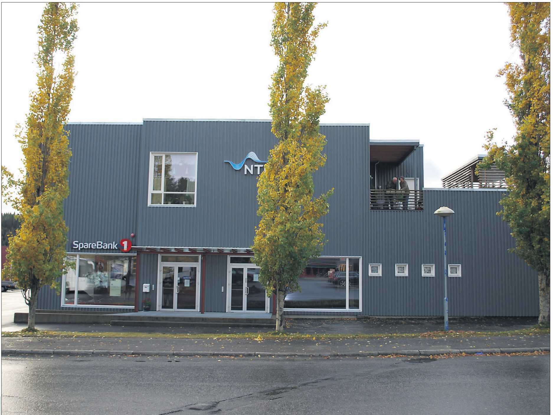
NTE-BYGGET: I starten av 2016 blir det igangsatt en relativt omfattende ombygging av lokalene som skal brukes av den kommende tannklinikken i NTE-bygget.
