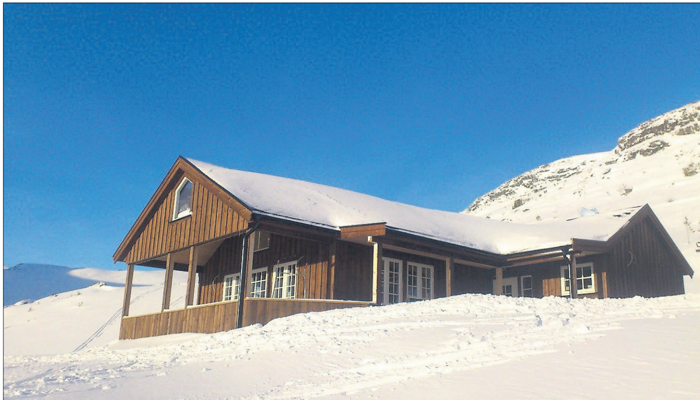
VINTER: Nye Snøhytta på Geitfjellet begynner nå å nærme seg ferdig, og bli klar for utleie.
