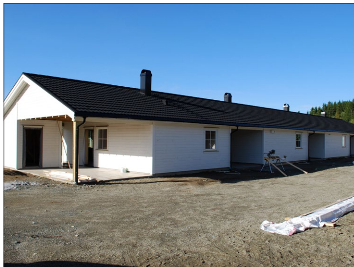
KOMMUNALE: Leiligheter under bygging Bergsmohaugen
